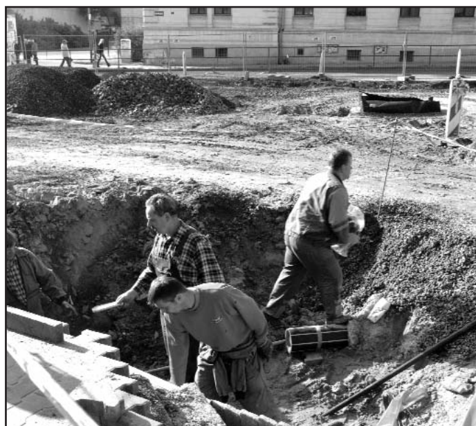
Přeložky sítí, tedy stavebně nejnáročnější část kruhového objezdu, jsou v těchto dnech již dokončeny. Foto Eva Břeňová
