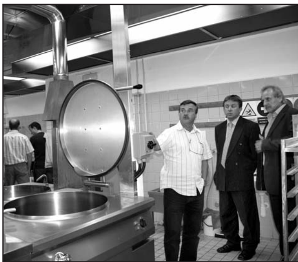
Starosta Chlupáč společně s místostarostou Tvrdíkem se osobně přesvědčili, zda modernizace vzduchotechniky proběhla dle projektu. (eva)
