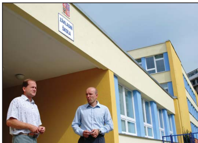
Místostarosta Václav Červín společně s ředitelem školy Martinem Hrdinou převzali od dodavatele stavby zrekonstruovaný objekt. Foto Eva Břeňová
