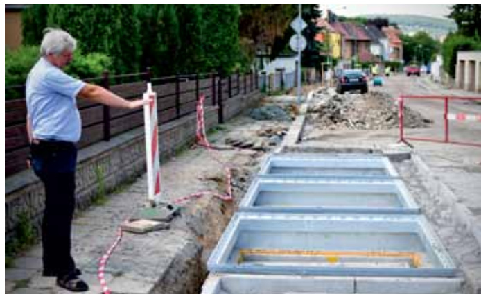
Prozatím poslední podzemní kontejner je budován v Dalimilově ulici. Na snímku vedoucí odboru životního prostředí P. Gryndler. Foto M. Bubeníčková
