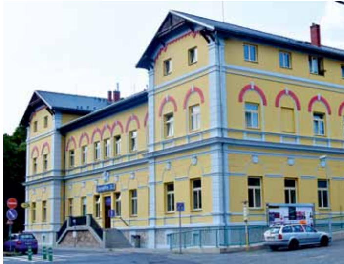
Výpravní budova horního vlakového nádraží pocházející z roku 1898 prošla generální opravou. Foto Eva Břeňová
