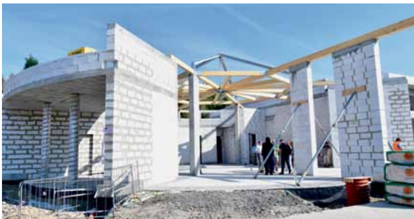
Hrubá stavba je v těchto dnech hotová.
