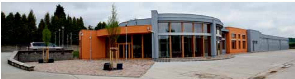
Takto vypadá právě dokončená stavba Centra pro výzkum geotermální energie RINGEN nacházející se v zadní části Jiříkových kasáren. Foto Eva Břeňová
