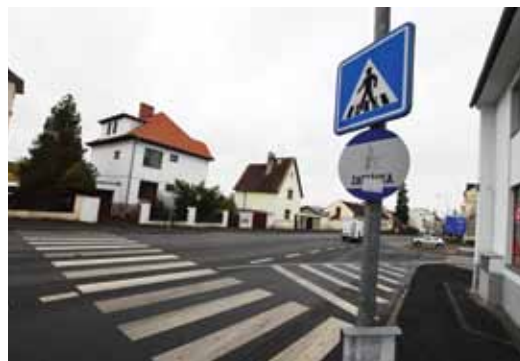
Pohled na stávající přechod pro chodce, který je dlouhý a nemá parametry odpovídající bezpečnosti.
