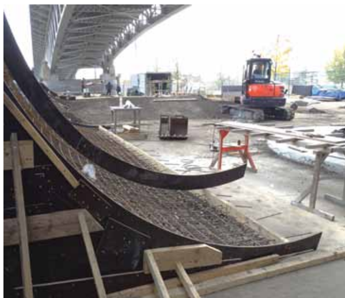
Oprava skateparku skončí na jaře.
