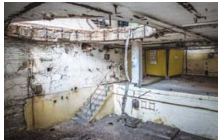
Takto vypadají vnitřní prostory objektu bývalé varny. Foto: Anna Hrochová
